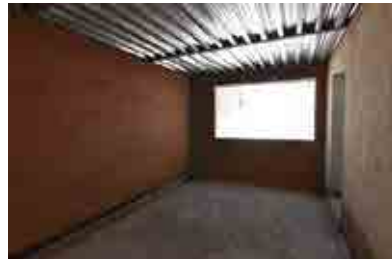
Ampliación terrazas traseras vista 02
