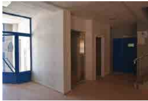
Hall Ascensor y aseo adaptado PB
