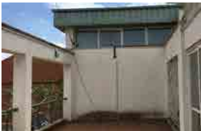
Manchas de humedad en fachada interior en terrazas y patios, edificio de servicios.
