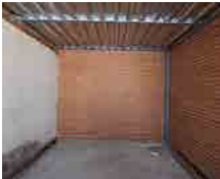
Ampliación terrazas traseras vista 01
