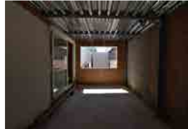
Ampliación terrazas traseras vista 03
