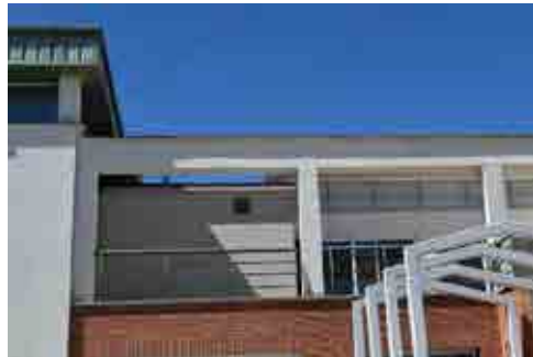
Vista exterior volumen ascensor y cuarto de limpieza.
