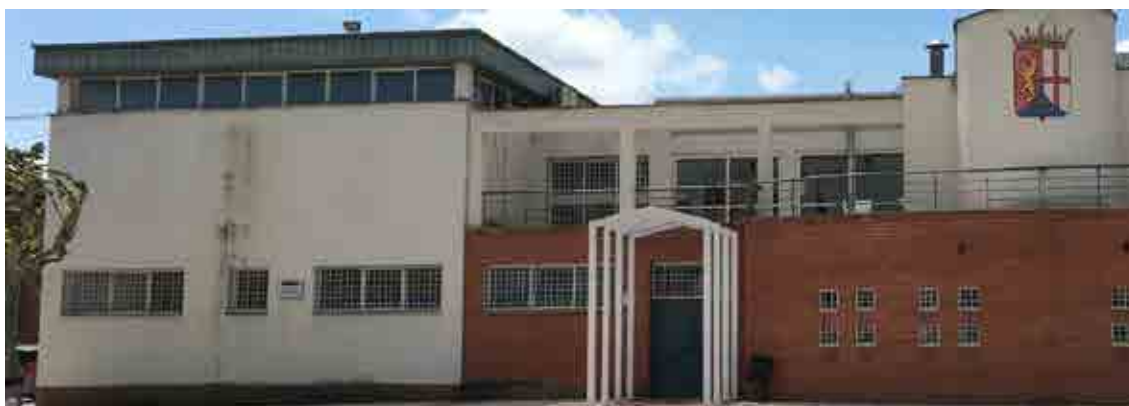
Manchas de humedad en fachada principal, edificio de servicios.
