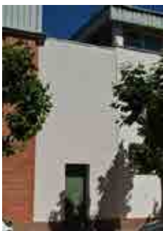
Vista exterior fachada S-E ampliación terrazas.
