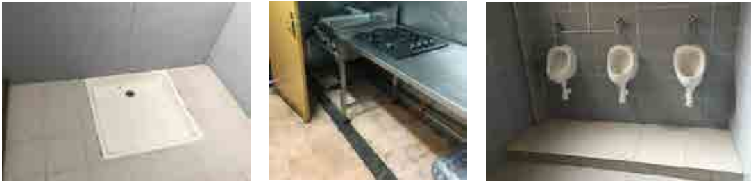
Solado y alicatado, vestuarios, aseos y cocina
